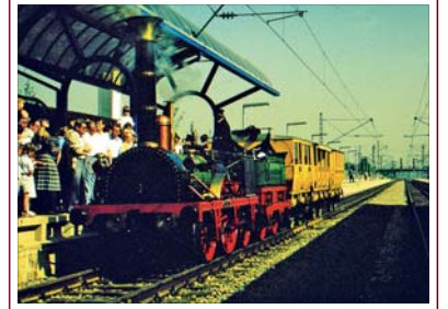
Der „Adler“ fährt in den neuen Bahnhof Waldhof ein. Foto: Schillinger
